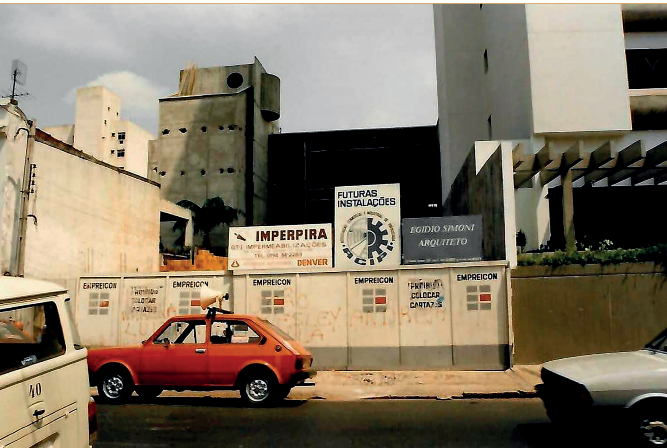
Sede própria da ACIPI em construção, 1988. Acervo ACIPI.
